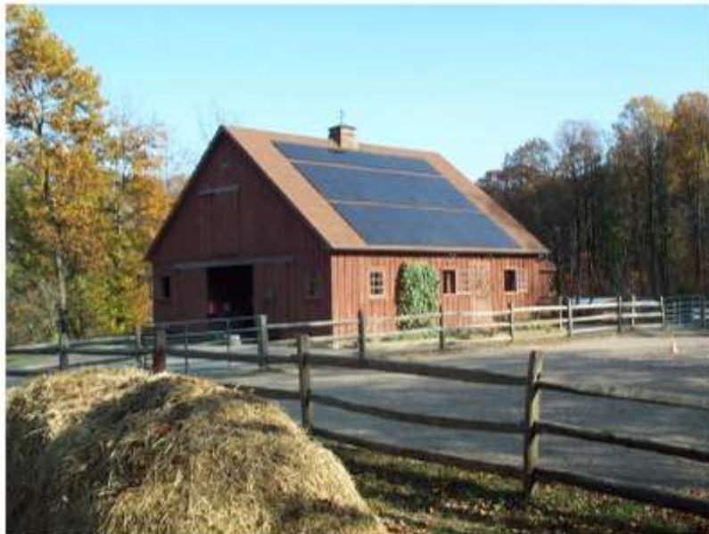
Thin-film a-Si PV array
